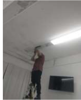
Ilustración 15 Cambio de lámparas obsoletas con balastro por lámparas de luces led
