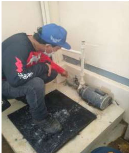
Ilustración 16 Mantenimiento correctivo para equipo de aire acondicionado, instalación eléctrica para bomba de agua
