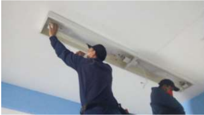
Ilustración 15 Cambio de lámparas obsoletas con balastro por lámparas de luces led
